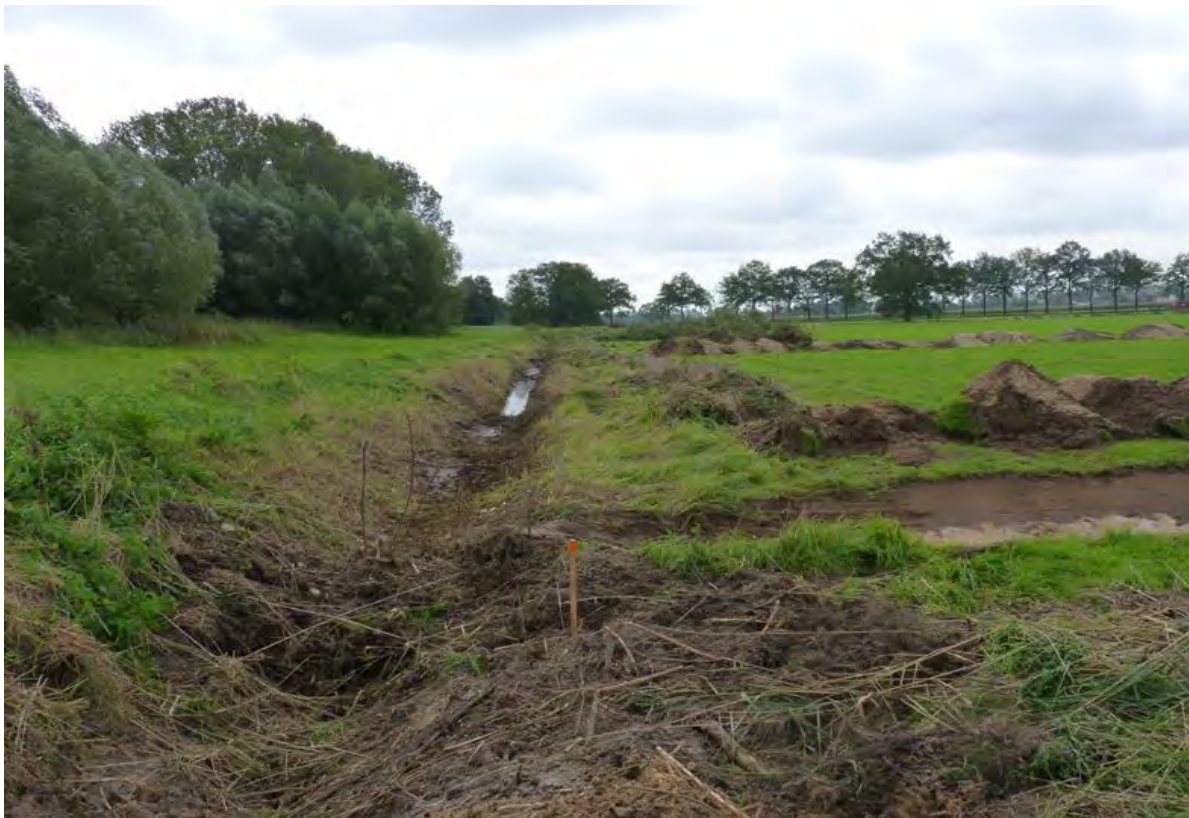
Oude helling met sloot, die gedicht wordt; rechts herstel oude slotenstelsel
