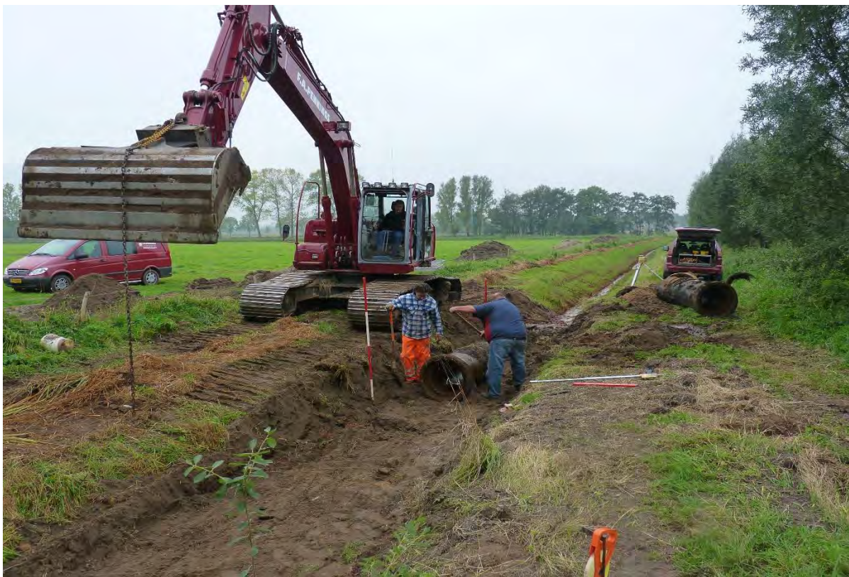
Verhoging van de slootbodem en omhoog brengen van de duiker.
